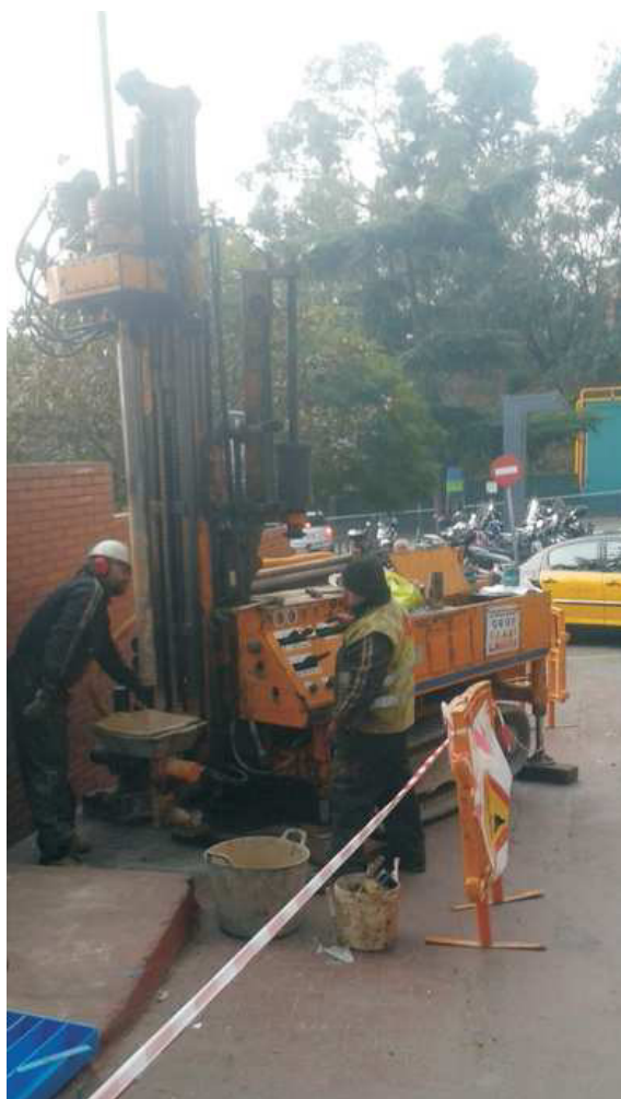
Fotografia 4. Execució sondeig S-1R.
