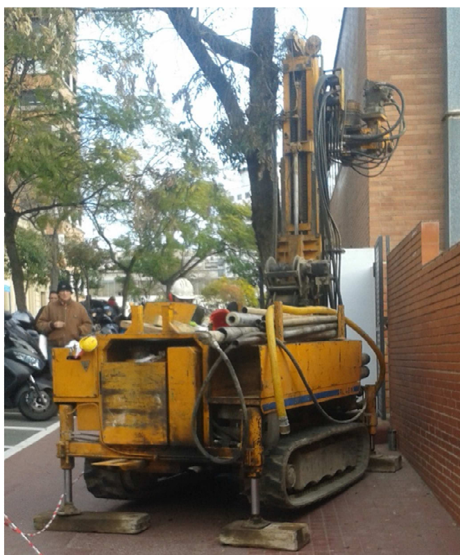
Figura 1. Execució del sondeig S-1R.
