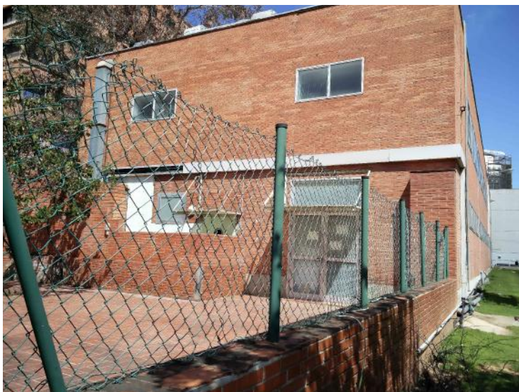
Foto 2 – Vista exterior de l'Edifici del pavelló d'accés
